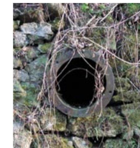
Röhre der Wasserzuleitung in der Mülimauer
